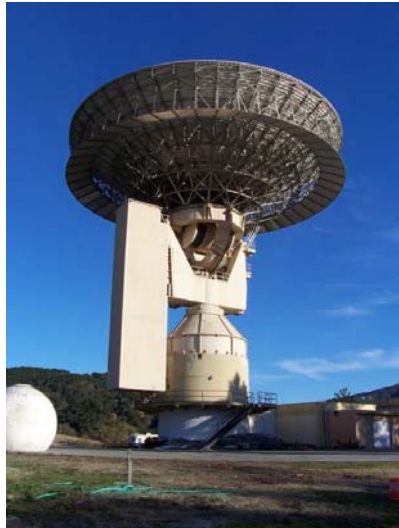
obr. Jamesburská parabola 32m průměr
